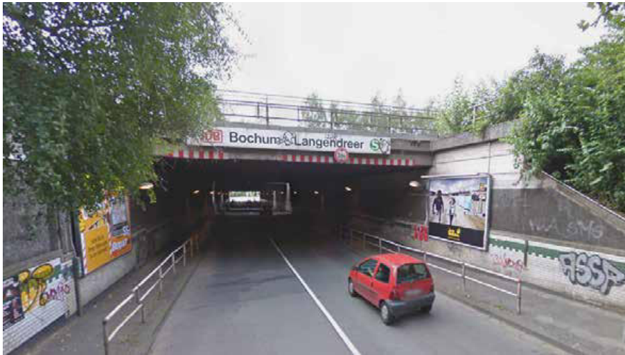
Brückenbauwerk am S-Bahnhof Langendreer
