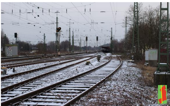
Gleistrasse beim S-Bahnhof Langendreer West über die Ümminger Straße
