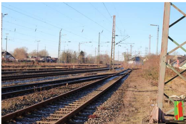
Gleistrasse Höhe Rüsingstraße (Blick nach Westen)
